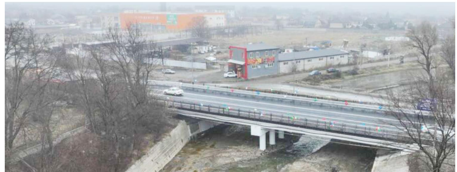
ности. И вот сегодня здесь двухполосное сооружение протяжённостью 48 метров с тротуарами с обеих сторон. Реконструкция моста позволила в разы увеличить грузоподъемность и пропускную способность.
